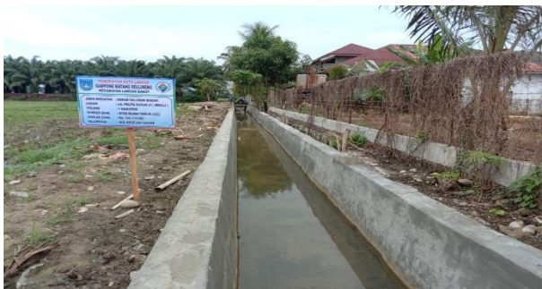
Gambar 5.6 Rehab/Renovasi Saluran Irigasi
