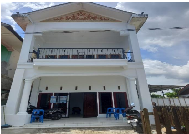
Gambar 5.7 Pemeliharaan Bangunan Balai Meusapat
