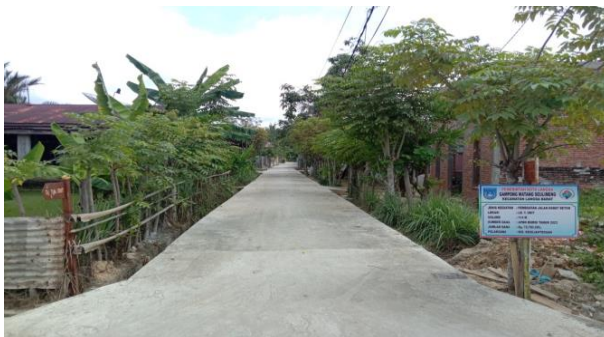
Gambar 5.5 Pembangunan Rabat Beton Lr. T. Ubit
